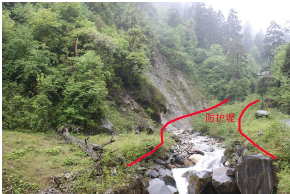
河道下游拟布设防护堤现状照片
