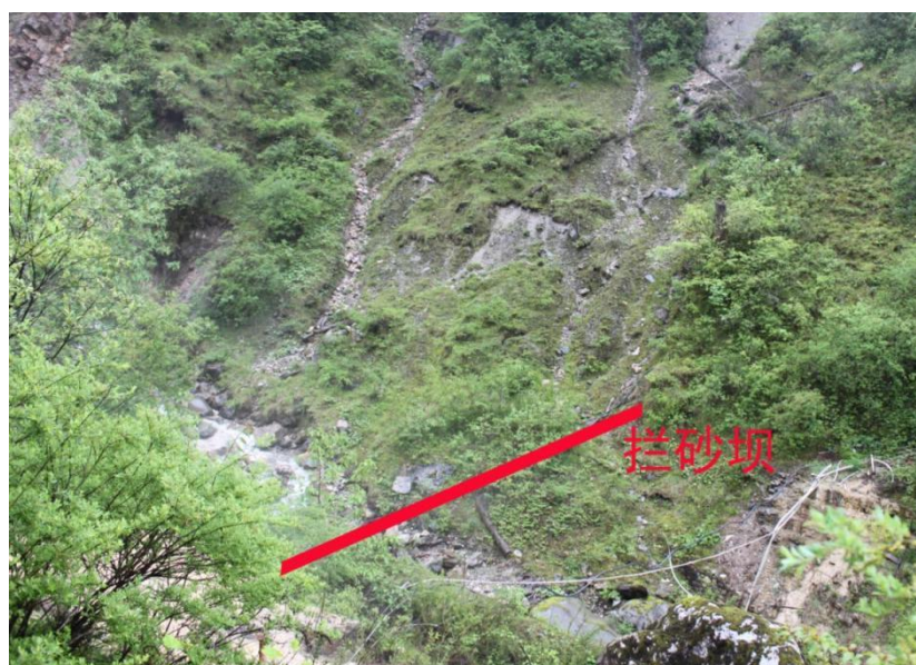
拟建拦砂坝现状照片
