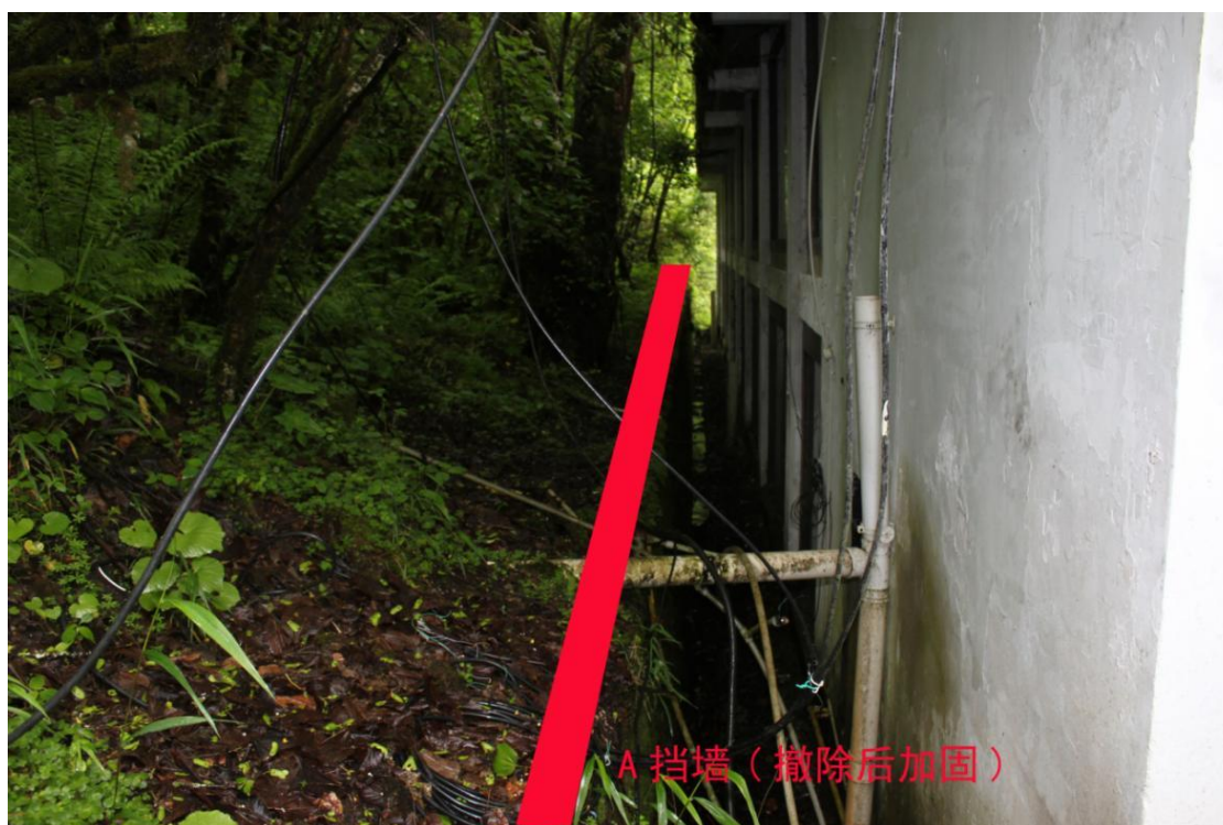
原挡墙现状照片
